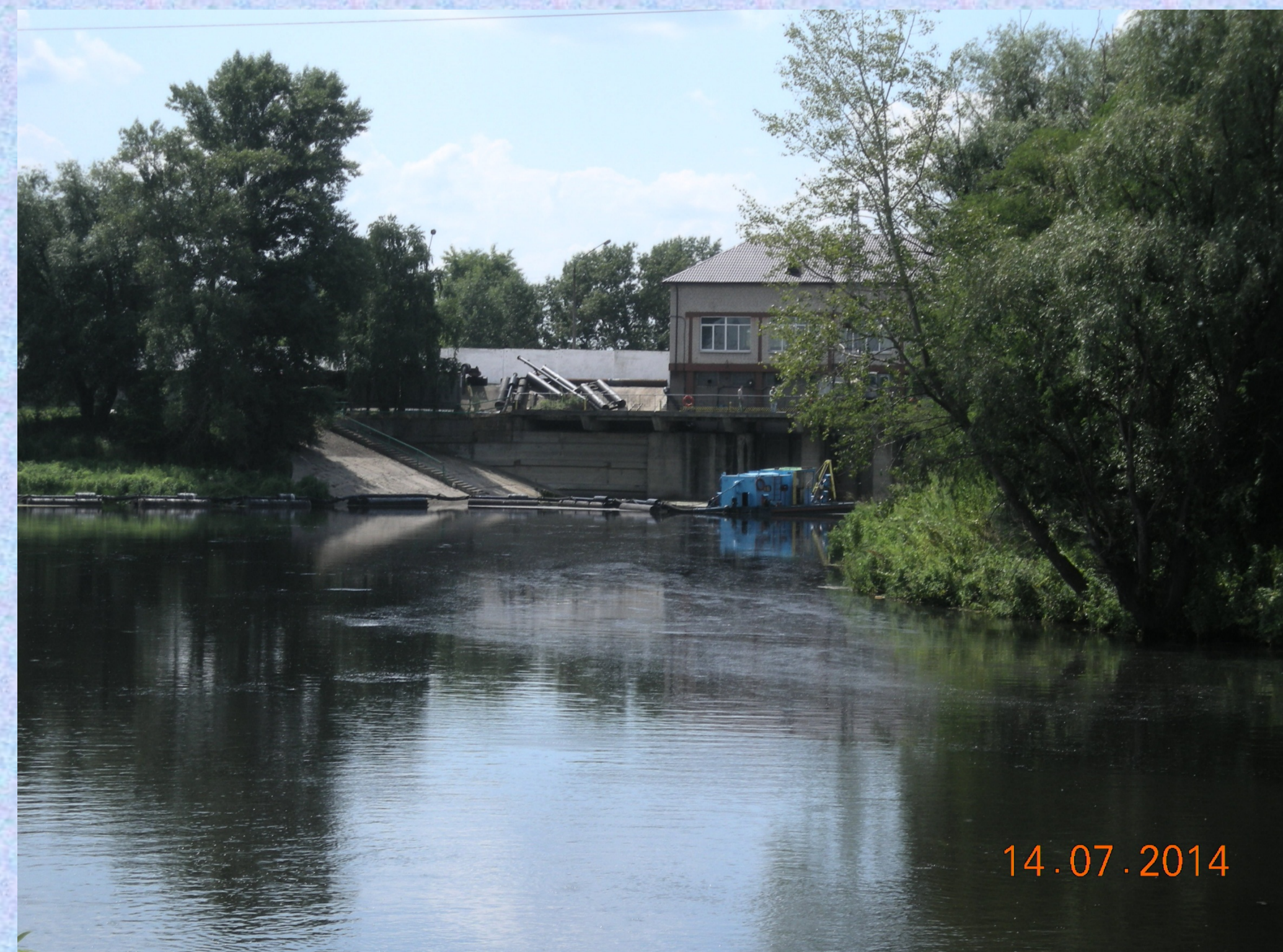
Станція перекачки зворотних вод БСА в р. Дніпро
