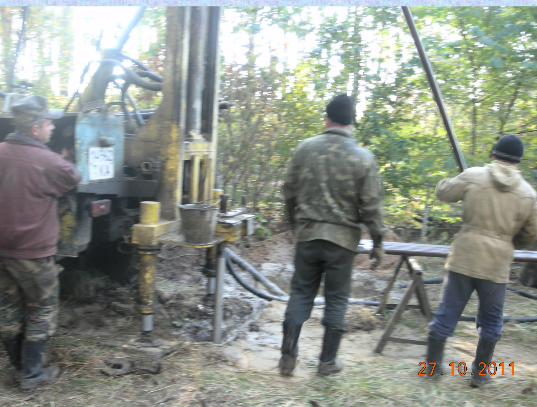
Процес буріння свердловини
